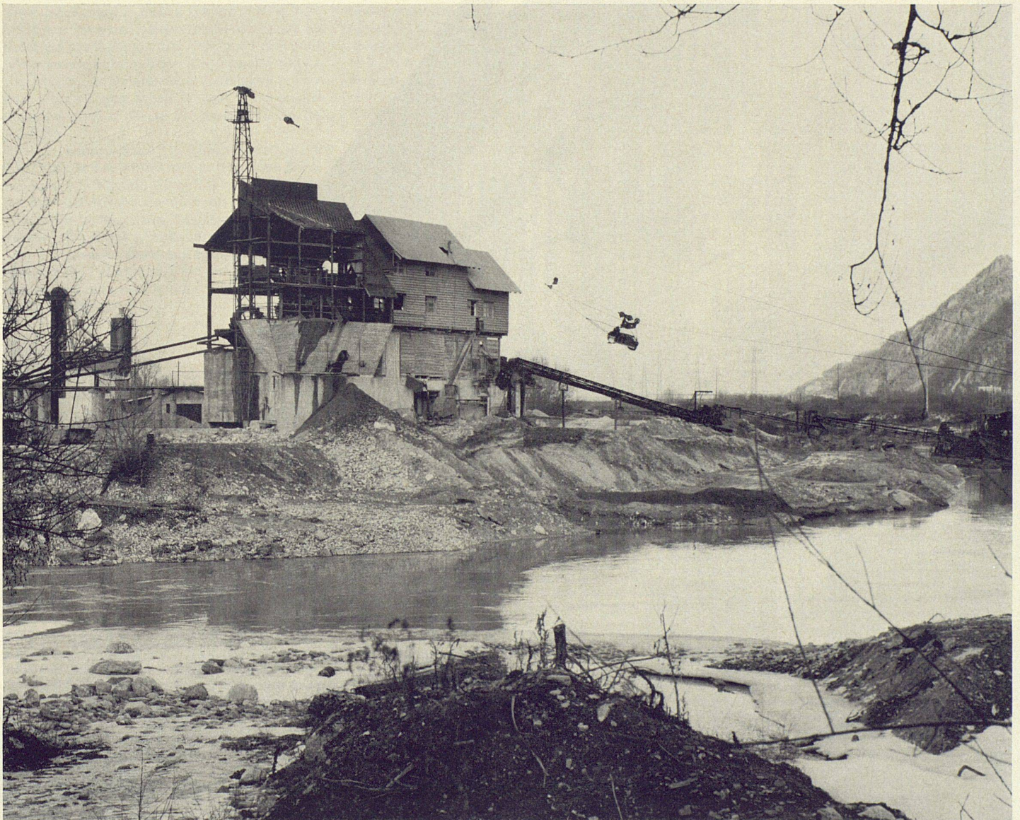
Rhone-Kieswerk Riddes, Wallis, gebaut 1940. Produktion von Granitkieseln, gewaschenem Sand und Fertigbeton
