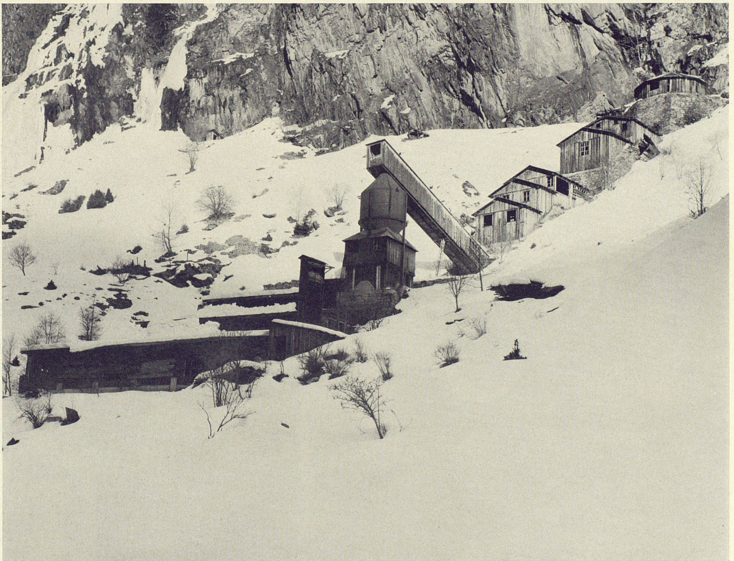
Blei- und Zinkmine Goppenstein Wallis; erstes geologisches Projekt 1930 H. F. Huttenlocher, Bern. Heute sichtbare Installation 1944 erbaut durch J. Dionisotti; Abbruch der Ausbeutung 1946
