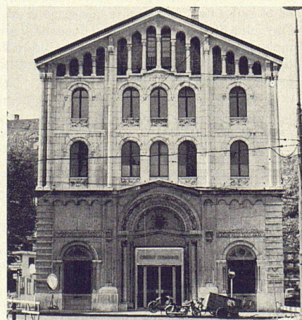
7 Façade orientale, état actuel
