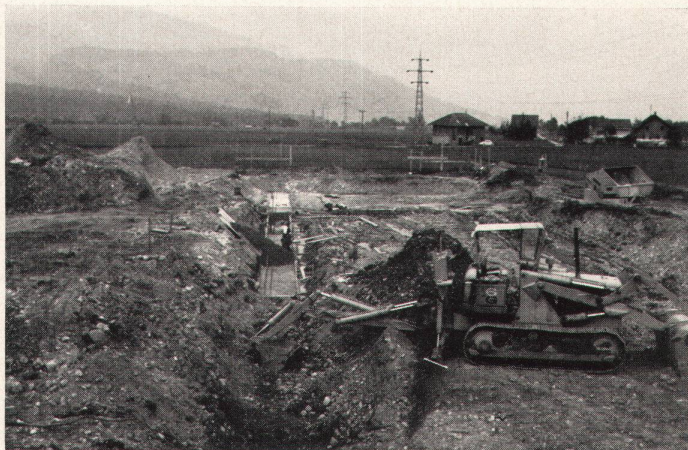
5 Erschließung der Industriezone in Giswil OW
