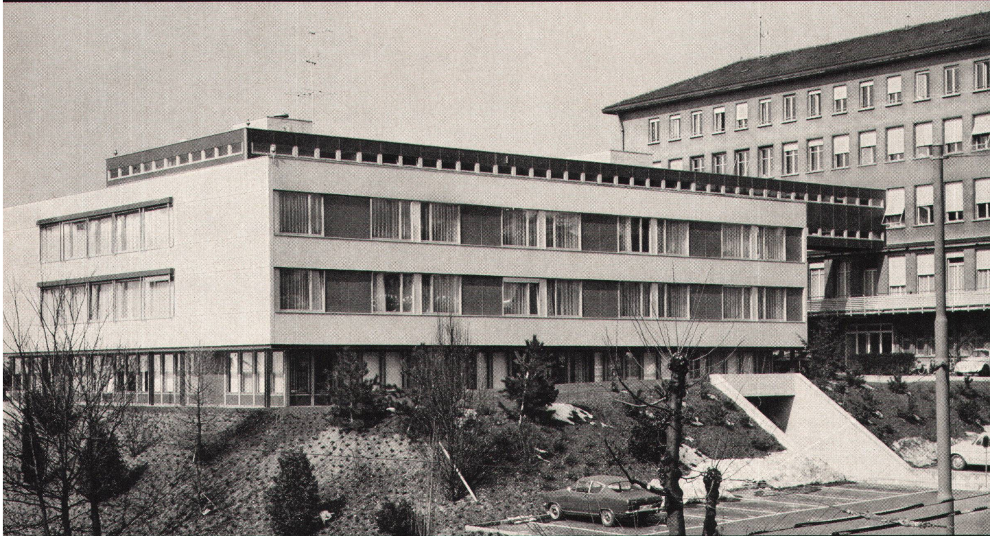
Kantonsspital Lausanne Anbau Chirurgietrakt Architekten: HH. P. Bonnard, J.P. Cahen, J. Lonchamp, Lausanne
