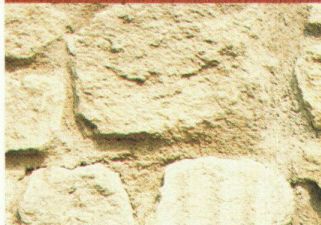
unregelmässigem Bruchsteinmauerwerk
