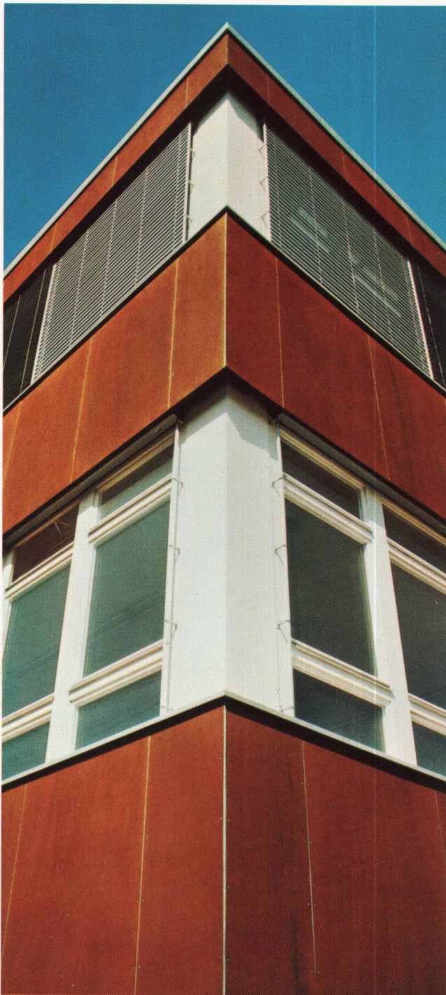
Industriegebäude: Gebr. Gläser AG, Schreinerei, 5513 Dättwil
