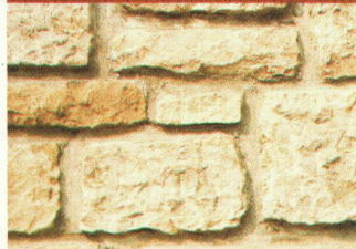
regelmässigem Bruchsteinmauerwerk
