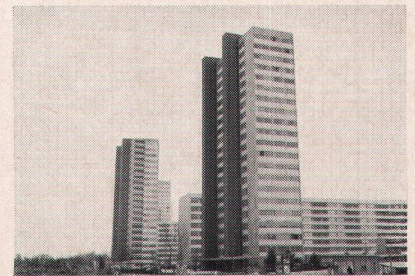
Dichthalten: Tscharnergut, Bern
