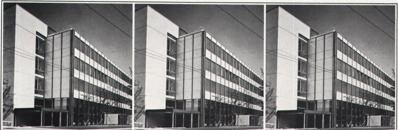
Die Firma Geilinger (Geilinger & Co., Metallbau, Winterthur) lieferte Brüstungsverkleidungen (750m 2 ), Stützenverkleidungen (380 Stück) sowie Leichtmetall- und Holz/Metall-Fenster (2400m 2 ).
