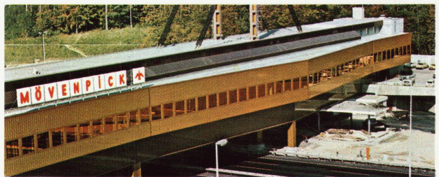
Autobahn-Restaurant Würenlos – Infrastop Gold 40/26 Architekten H. J. Wipf / F. Klaus, Zürich
