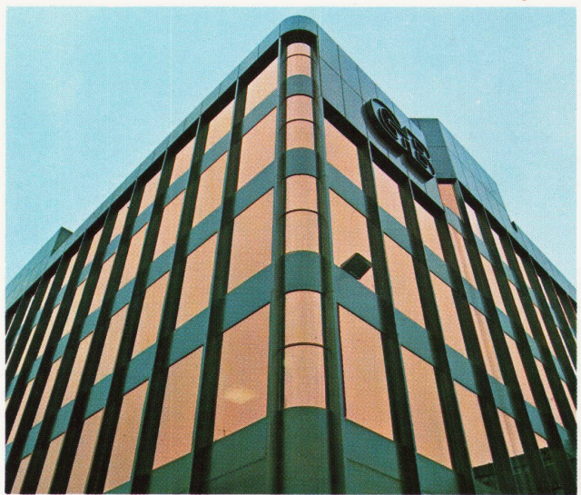
Gewerbebank Baden – Infrastop Gold 30/23 Hafner & Wiederkehr Architekten, Zug
