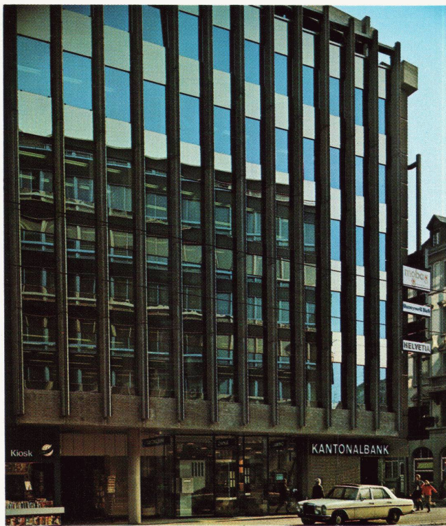
Geschäftshaus Aeschenvorstadt, Basel – Phonstop/Infrastop Auresin 39/28 Burckhardt Architekten SIA, Basel
