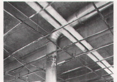
Die Decken-Installationen und die Betondecke sind dank den unbrennbaren PAVAROC-Mineralfaserplatten absolut unversehrt.
