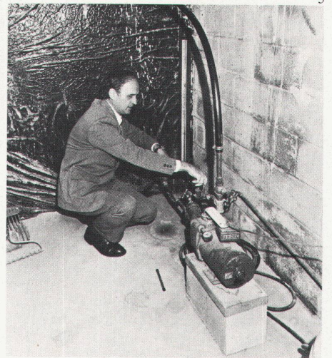
1 La maison solaire de M. Harry Thomason, dans le Maryland. 2 La piscine chauffée à l'énergie solaire. 3 La pompe à eau qui actionne, à la cave, le chauffage solaire.
