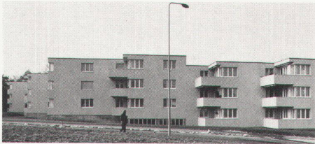
Ostfassade des Wohnblocks A
