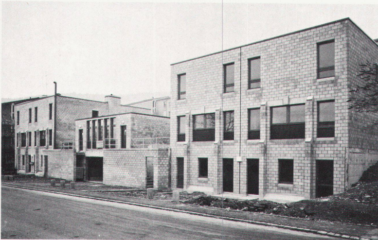
Gesamtansicht von der Fachstrasse her
