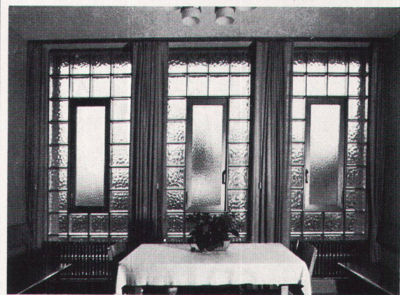
Glasbausteinfenster mit Anticorodal- Drehflügel in Sitzungszimmer.
