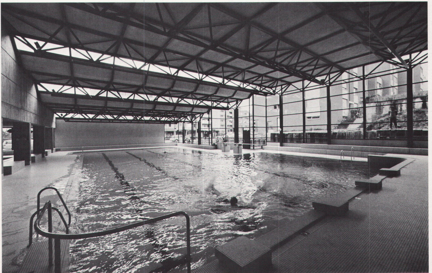
Innenansicht des Schwimmbassins
