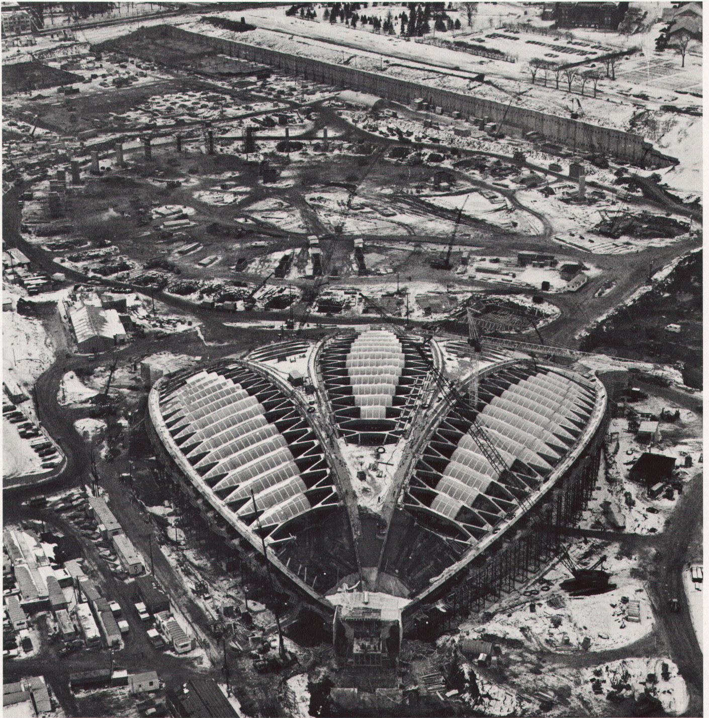
En bas, la structure du vélodrome, en haut, les fondations stade: état des travaux en novembre 1974 (Photos: Sipa-Press)
