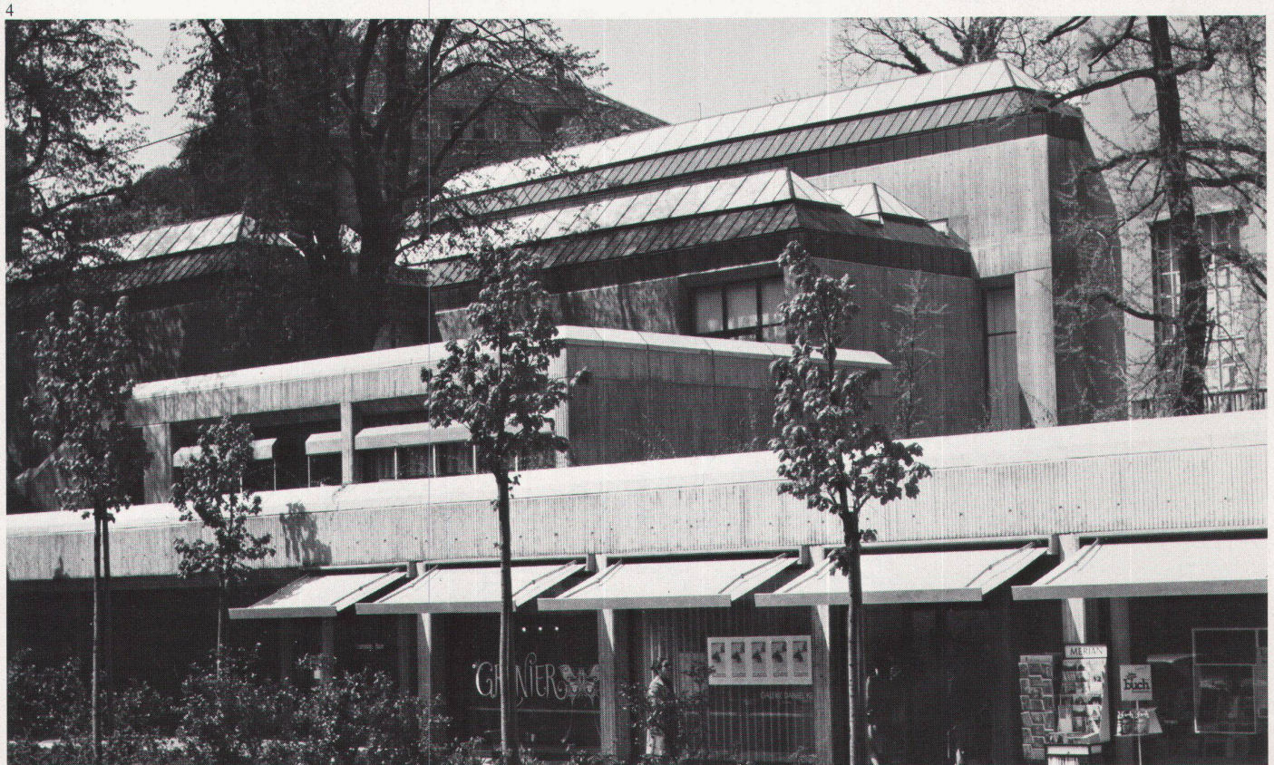
2 Der Erweiterungsbau vom Hirschengraben aus. Im Vordergrund die überdeckte Einfahrt zur Spedition, darüber Restaurierungsateliers
