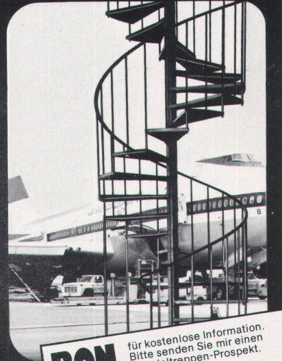
Nottreppe am neuen Fingerdock in Kloten
