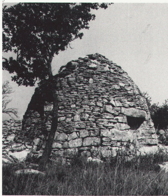
5 Kragsteinbau in der Provence, Luberon-Gebiet
