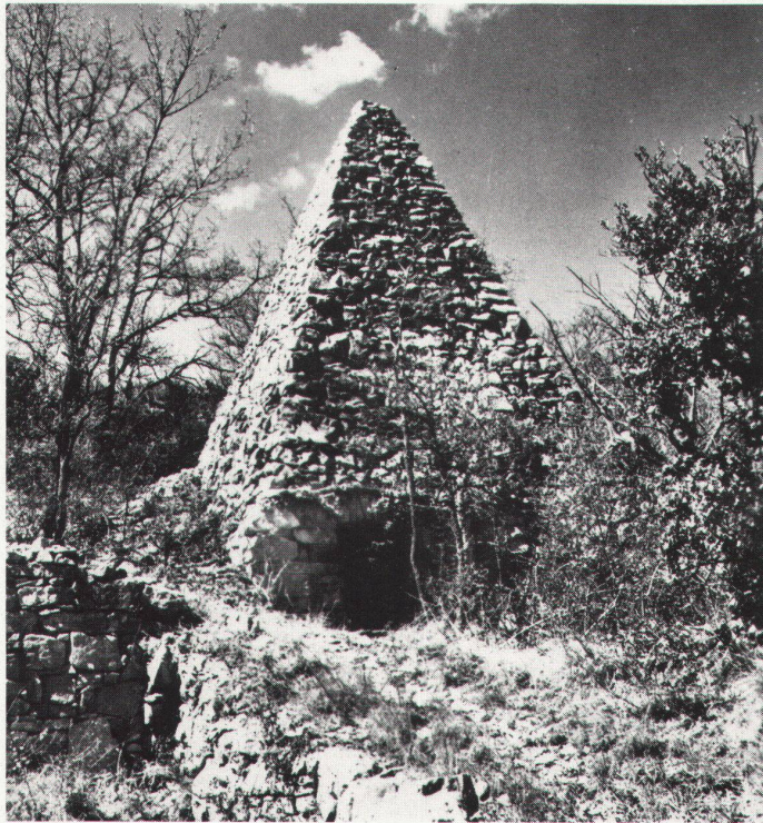
12 Kragsteinbau in der Provence. Innenschale bienenkorbformig, Aussenschale als Spitzpyramide
