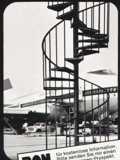
Nottreppe am neuen Fingerdock in Kloten
