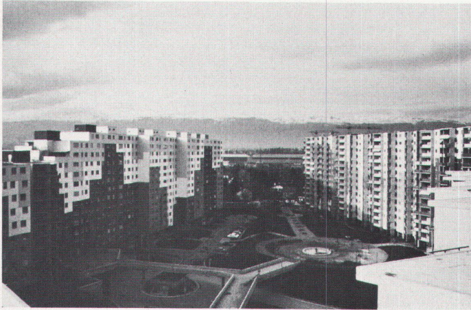
Der braune Hof von Südwesten
