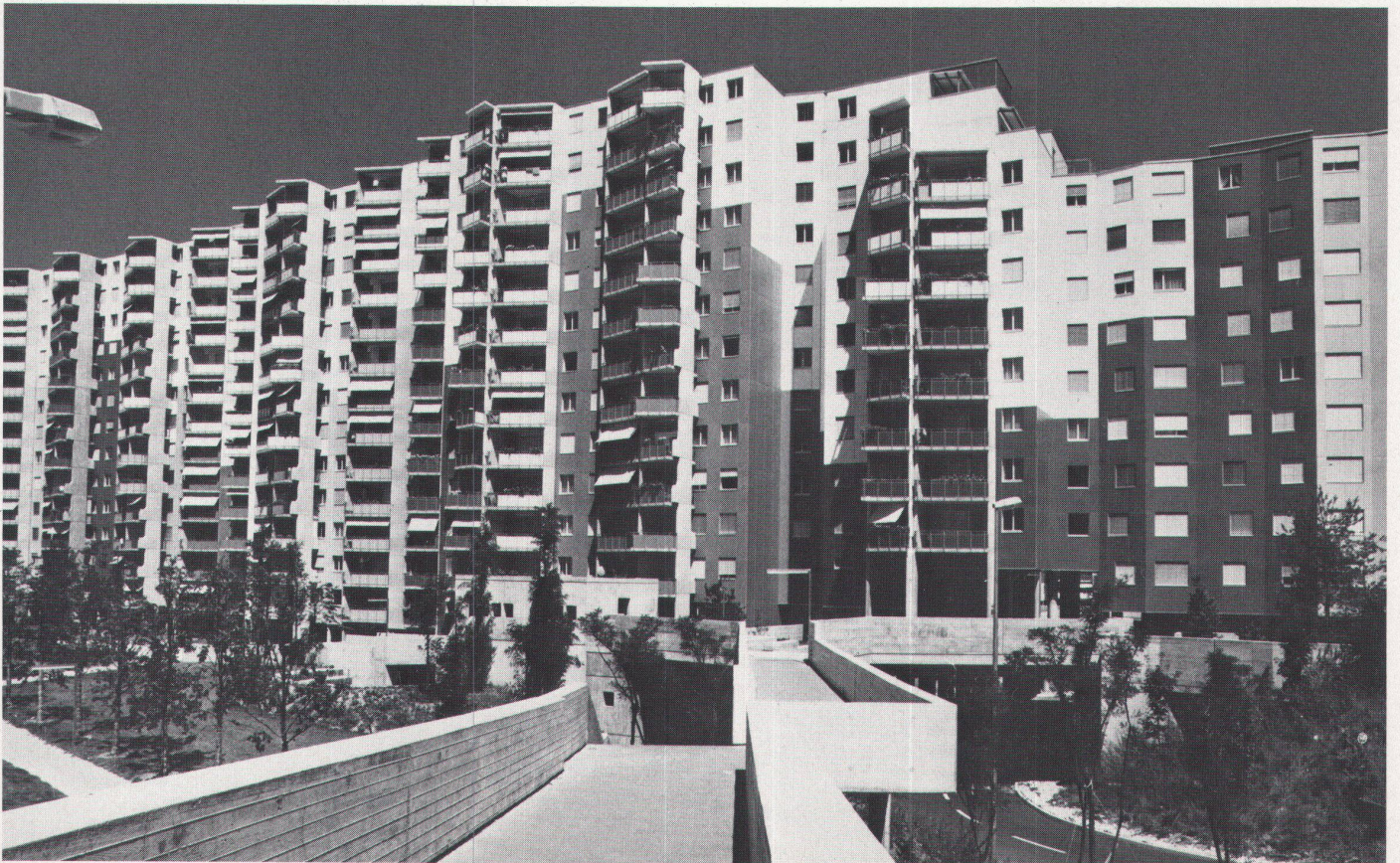
Blick von der Passerelle über die Route de Meyrin, rechts Hauptzufahrt, links Jugendhaus
