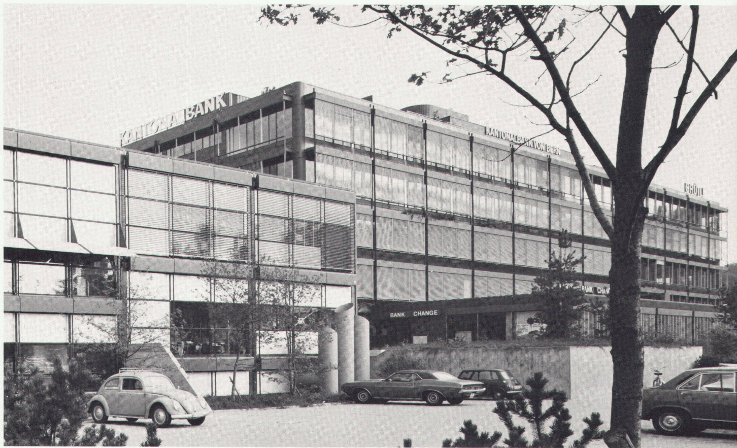
Gesamtansicht von Südwesten, links Bürohaus der Helfer Architekten AG, rechts Bürogebäude der Schweizerischen Grütli und der Kantonalbank von Bern
