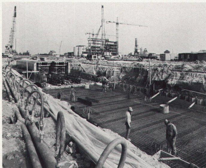
Pieux et charpente métallique
