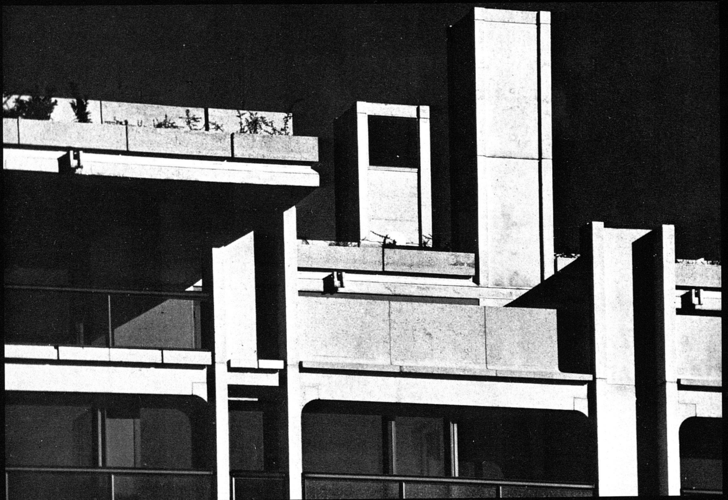
5 Detail der Dachterrasse
