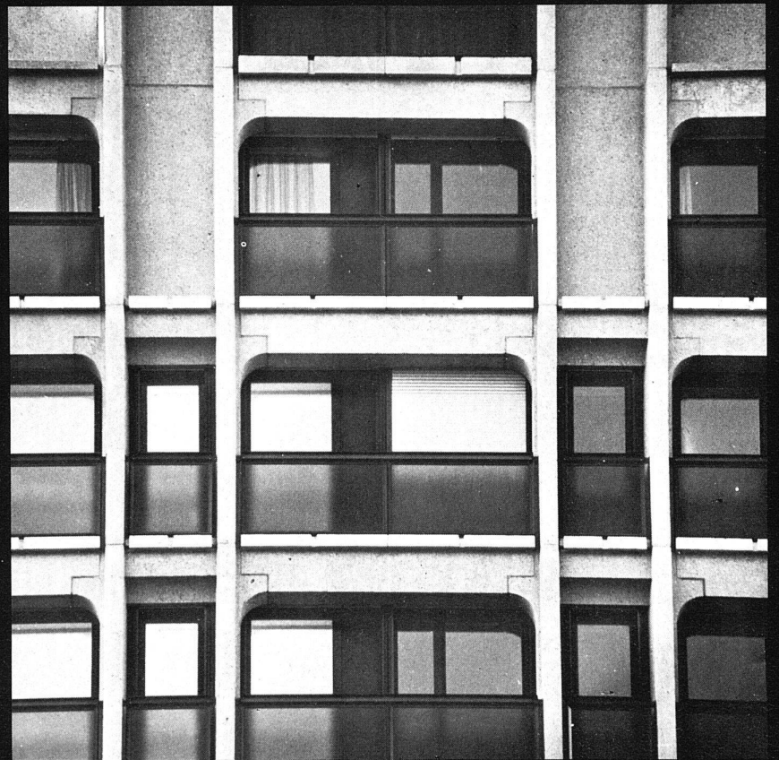
3 Fassadenausschnitt des Wohn- und Bürogebäudes
