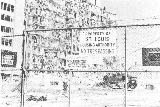
15 Vor dem Abbruch/avant démolition, 1975 (Foto E. A. Tomey).
