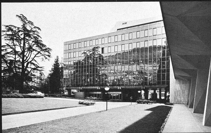
Fassadenpartie zum Eingangshof
