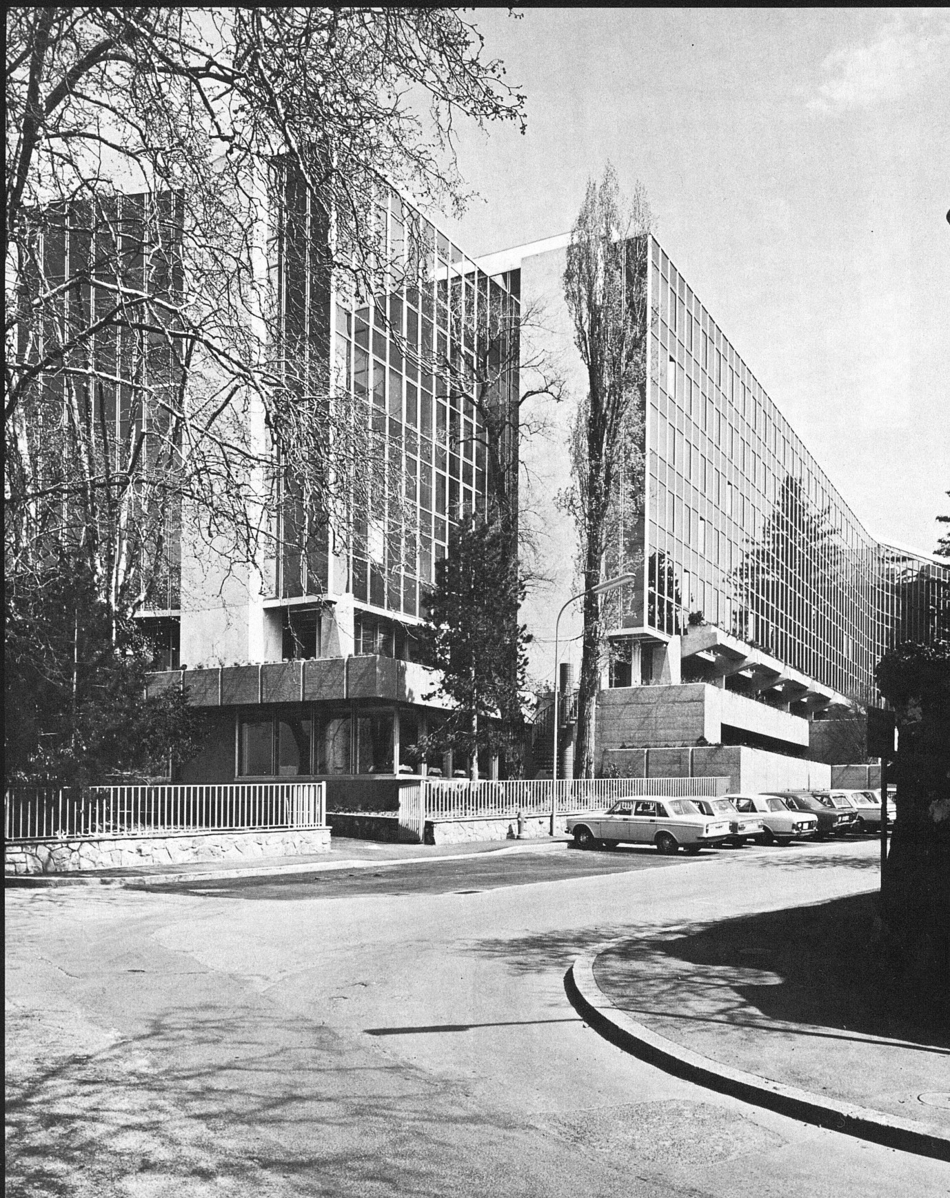
Südöstliche Fassadenpartie, von der Seestrasse her gesehen
