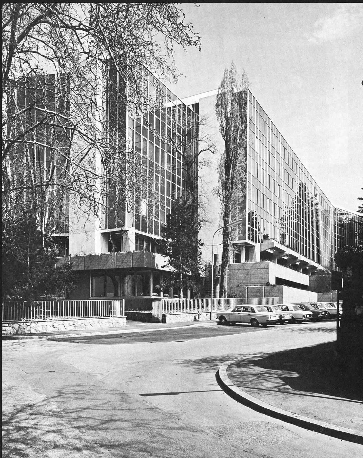
Südöstliche Fassadenpartie, von der Seestrasse her gesehen
