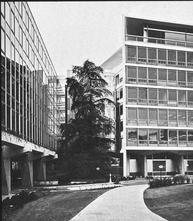
Verbindungsteil zwischen bestehendem Verwaltungsgebäude (rechts) und Erweiterungsbau (links)
