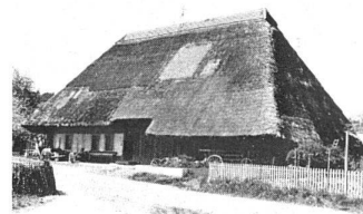
Strohhaus in Oberentfelden AG
