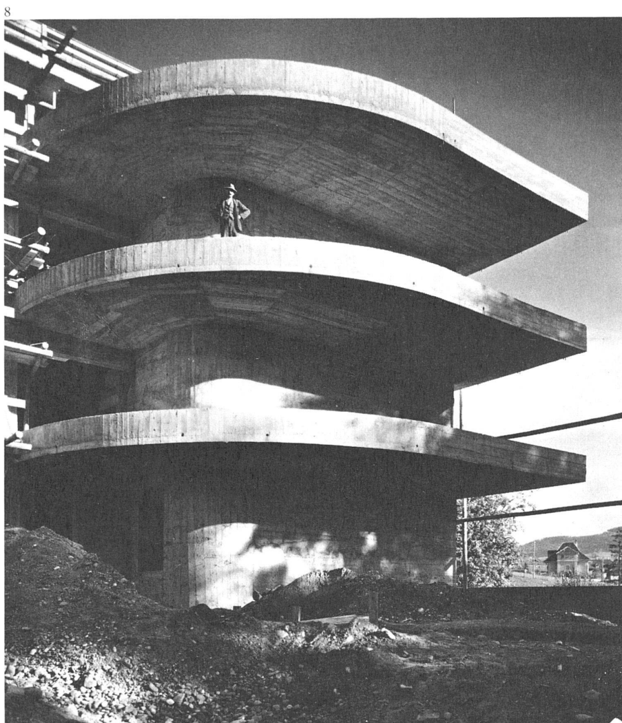
8 O. R. Salvisberg, Loryspital in Bern/hôpital Lory à Berne, 1926–29. Rohbau mit Kragplatten der Liegeveranden/gros-œuvre: vue des dalles des verandas
