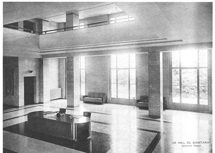
44 Vorhalle im Sekretariatsgebäude / un hall dans le bâtiment de Secrétariat.
