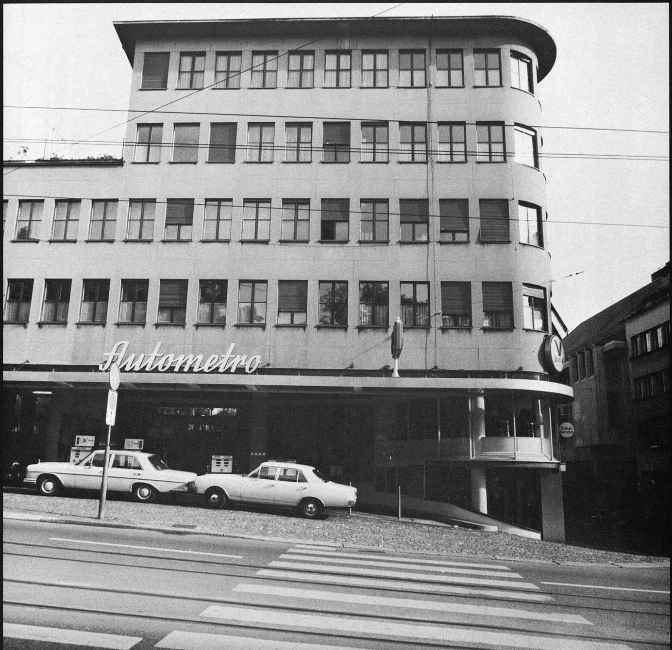
58 K. Knell, Architekt/architecte, Eckhaus Rämistrasse/Stadelhoferstrasse (1935).
