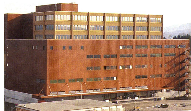
Jowa Grossbäckerei, CH-Volketswil, 1977 INFRASTOP-Silber 36/33 R. Busenhardt Architekten AG, Uster
