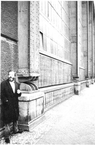
Prof. T. Buddensieg vor der Turbinenhalle der AEG (Foto s.v. Moos)
