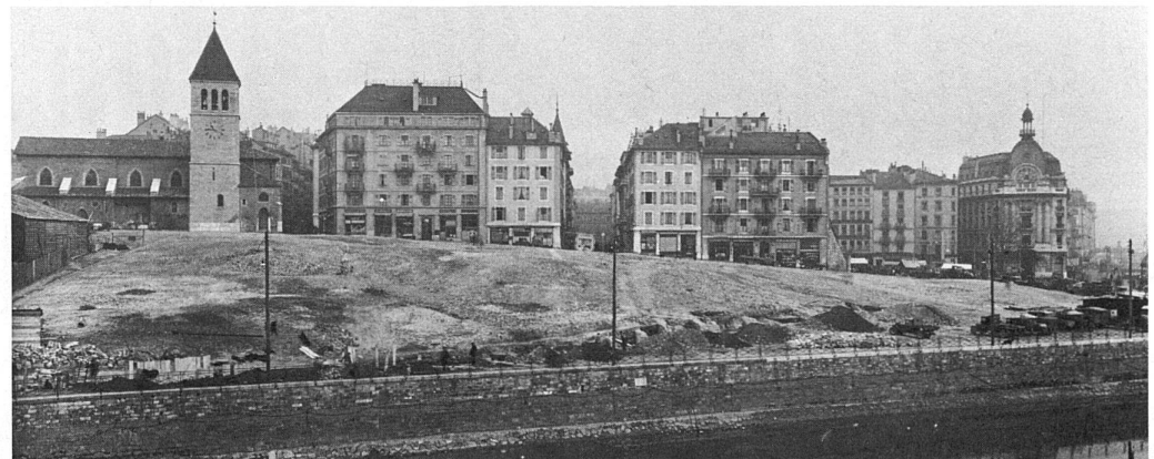
62 ... und/et nach den Abbrucharbeiten / après les démolitions 1932.
