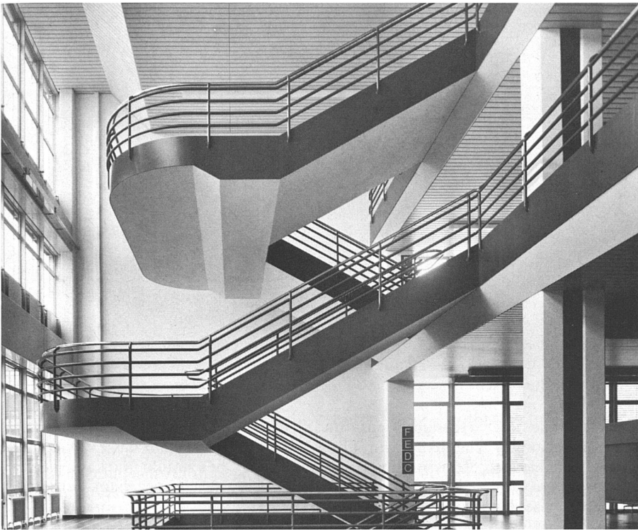
17 Freitragende Podesttreppen im Gemeinschaftstrakt
