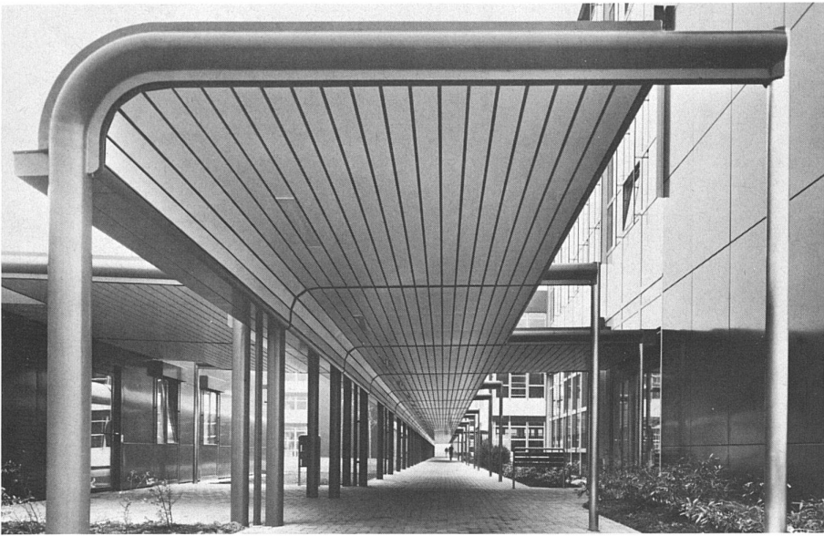
5 Verbindungsweg, links Abwartwohnungen, rechts Schultrakte
