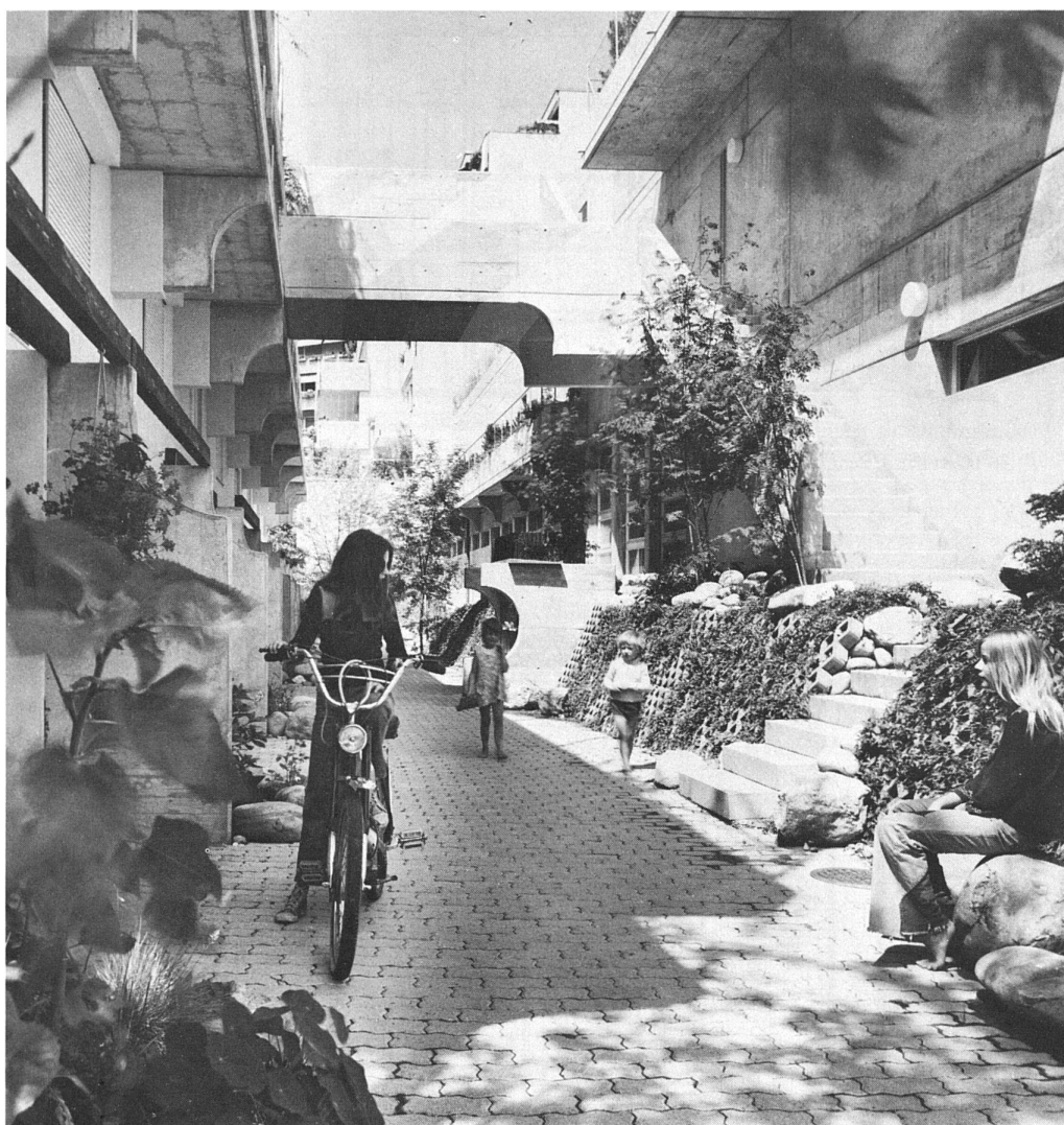
38 Überbauung / ensemble d'habitation «Fäld»-Stettli, Geroldswil ZH (Foto: Erwin Küenzi).
