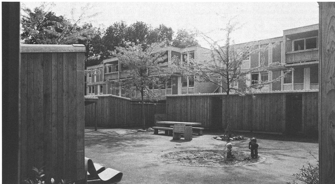
43 Atelier 5 Architekten / architectes: Überbauung «Lorraine» in / à Burgdorf BE (Foto: Jürg Bernhardt).
