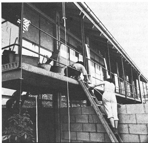
85 Beim Plattenlegen / carrelage.
