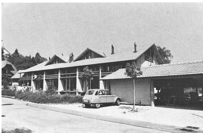
81 Wohnhausgruppe / groupe d'habitations Unterwindisch. Metron Architekten.
