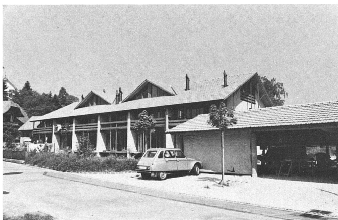
81 Wohnhausgruppe / groupe d'habitations Unterwindisch. Metron Architekten.
