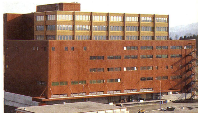
Jowa Grossbäckerei, CH-Volketswil, 1977 INFRASTOP-Silber 36/33 R. Busenhart Architekten AG, Uster
