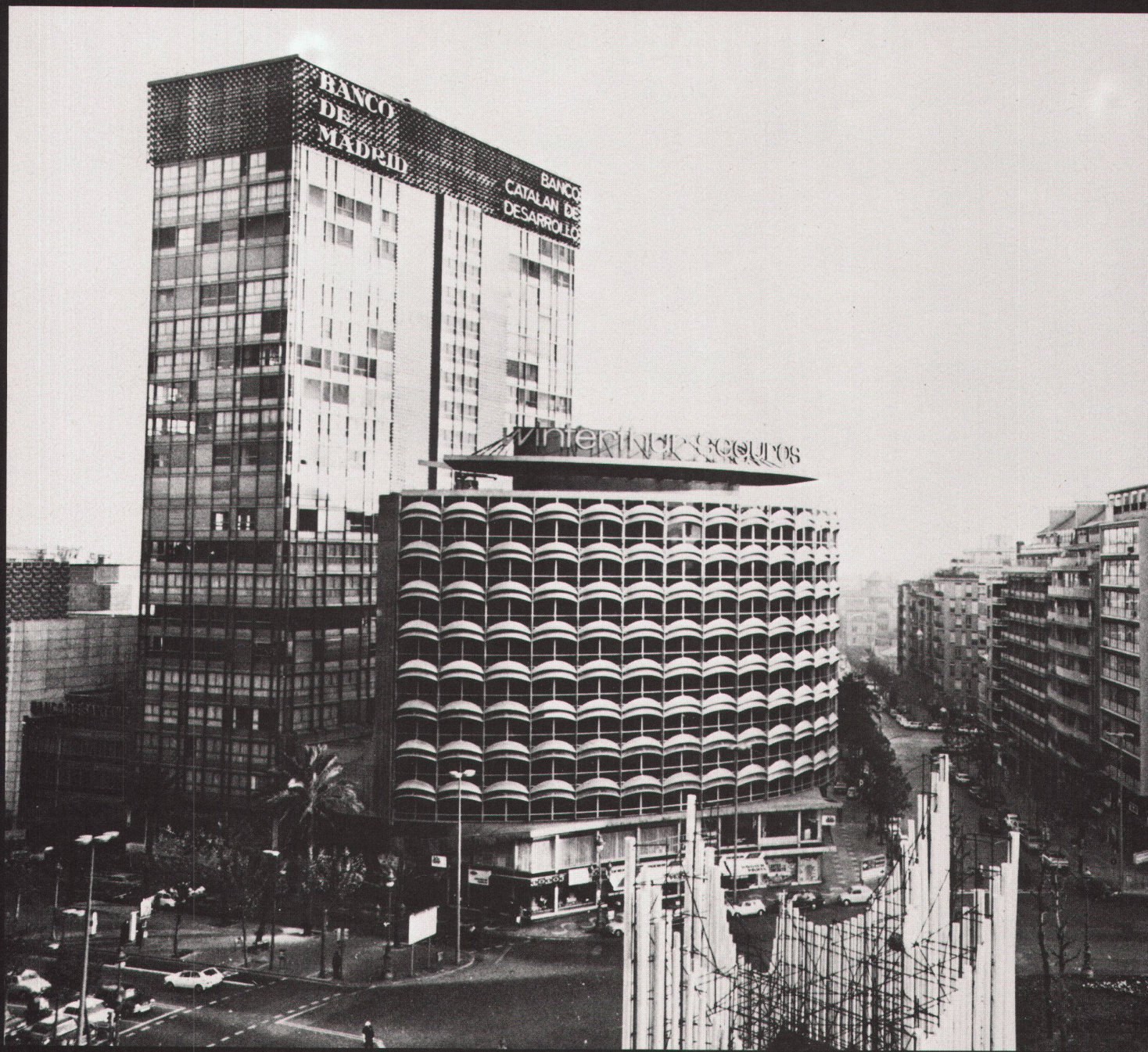
8 Barcelona. Plaza de Calvo Sotelo mit dem Gebäude der «Winterthur»-Versicherung (Architekt: Marc Saugey, BSA, Genf, 1961–65)/Plaza de Calvo Sotelo avec immeuble de la «Winterthur»-assurances (architecte: Marc Saugey, FAS, Genève). Foto: Oscar Tusquets
