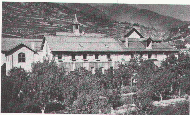
40 Sitten, VS. Kapuzinerkloster (17. Jh.). Zustand vor 1930. Südansicht, vor der Erweiterung nach Westen sowie der Aufstockung des Refektoriumsflügels. / Sion, VS. Couvent des Capucins, état avant 1930; vue côté sud, avant l'agrandissement vers l'ouest et l'addition à l'aile du réfectoire.
