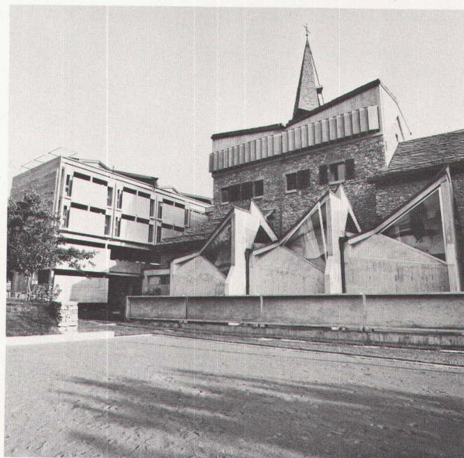
dergrund: Sakristei. / Vue côté nord. L'abbatiale avec chœur surélevé et tourelle. Au premier plan: la sacristie.
