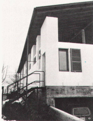
28 Nord-West-Ecke/ coin nord-ouest
