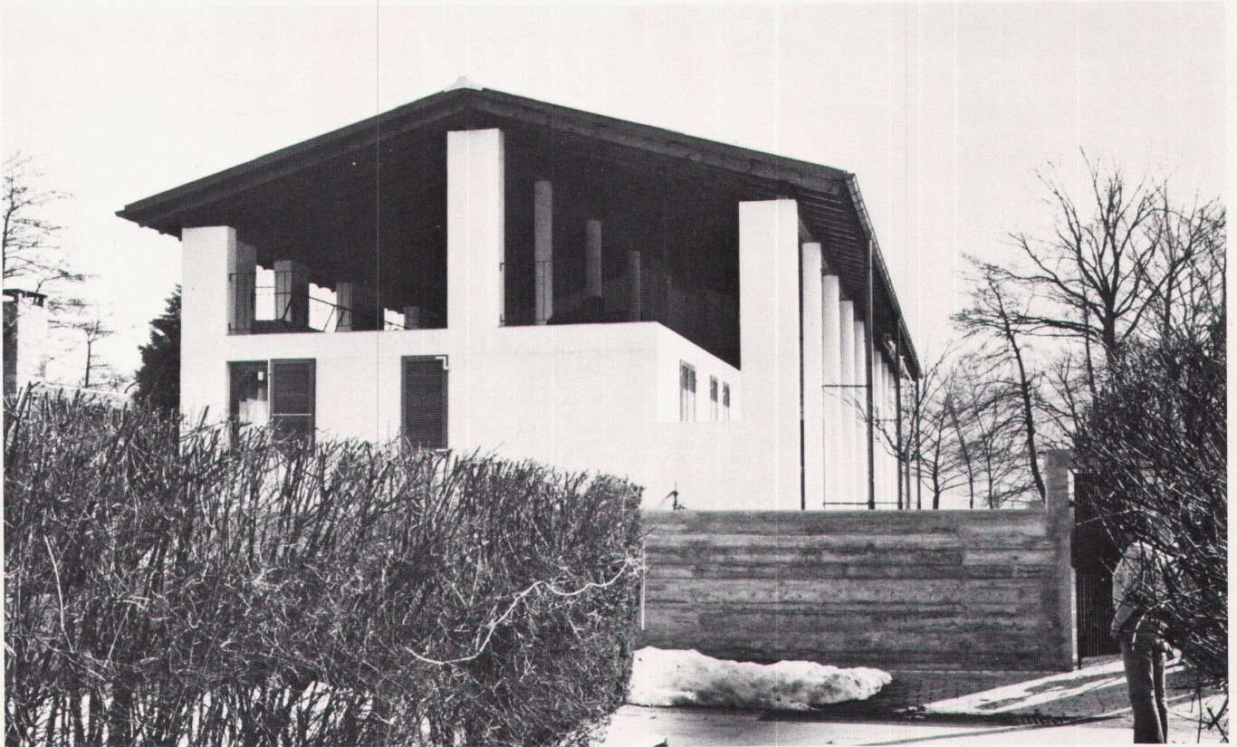
25 Westansicht/vue côté ouest
