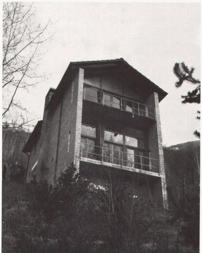
9 Westansicht/vue côté ouest
