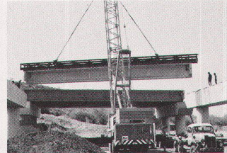
Losinger: Brückenbauten Al Hada (Saudi Arabien)
