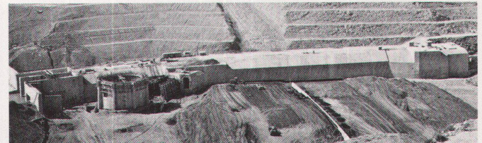
Elektrowatt: Staumauer (Marokko)
