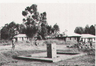
Helvetas: Brunnenanlage (Kamerun)
