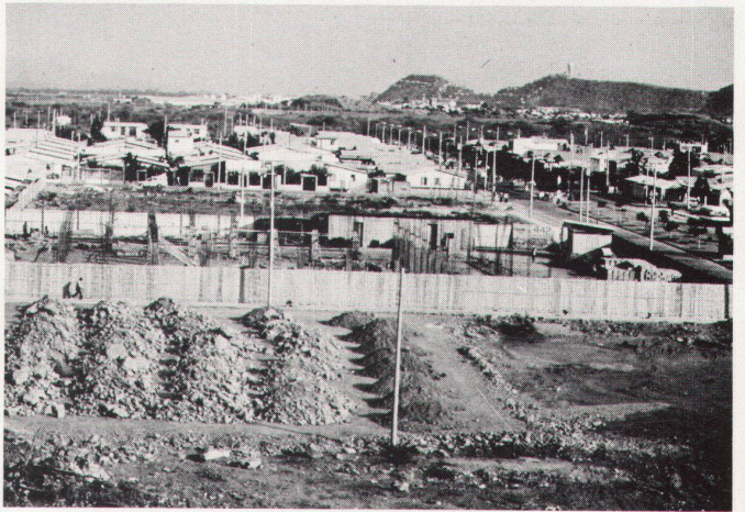
Das erste Einkaufszentrum entsteht / Le premier centre d'achat
