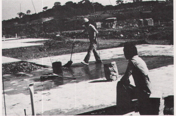
Auf das planierte Gelände kommt der Fussboden / On met le plancher sur le terrain aplani
