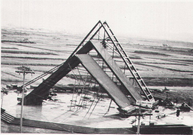
Eine Kirche im Bau / Une église en construction
