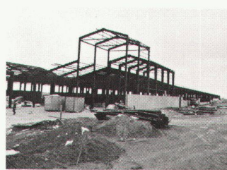
Suter & Suter, architectes, Bâle: une usine de câbles en Iran; état présent
