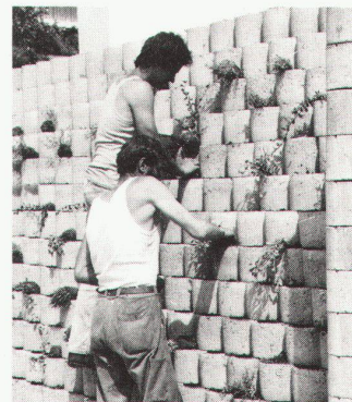
Die leicht begehbare Herbag-Böschungsteinsmauer wird bepflanzt.
