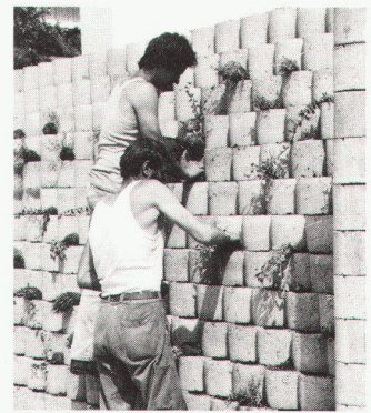
Die leicht begehbare Herbag-Böschungssteinmauer wird bepflanzt.
