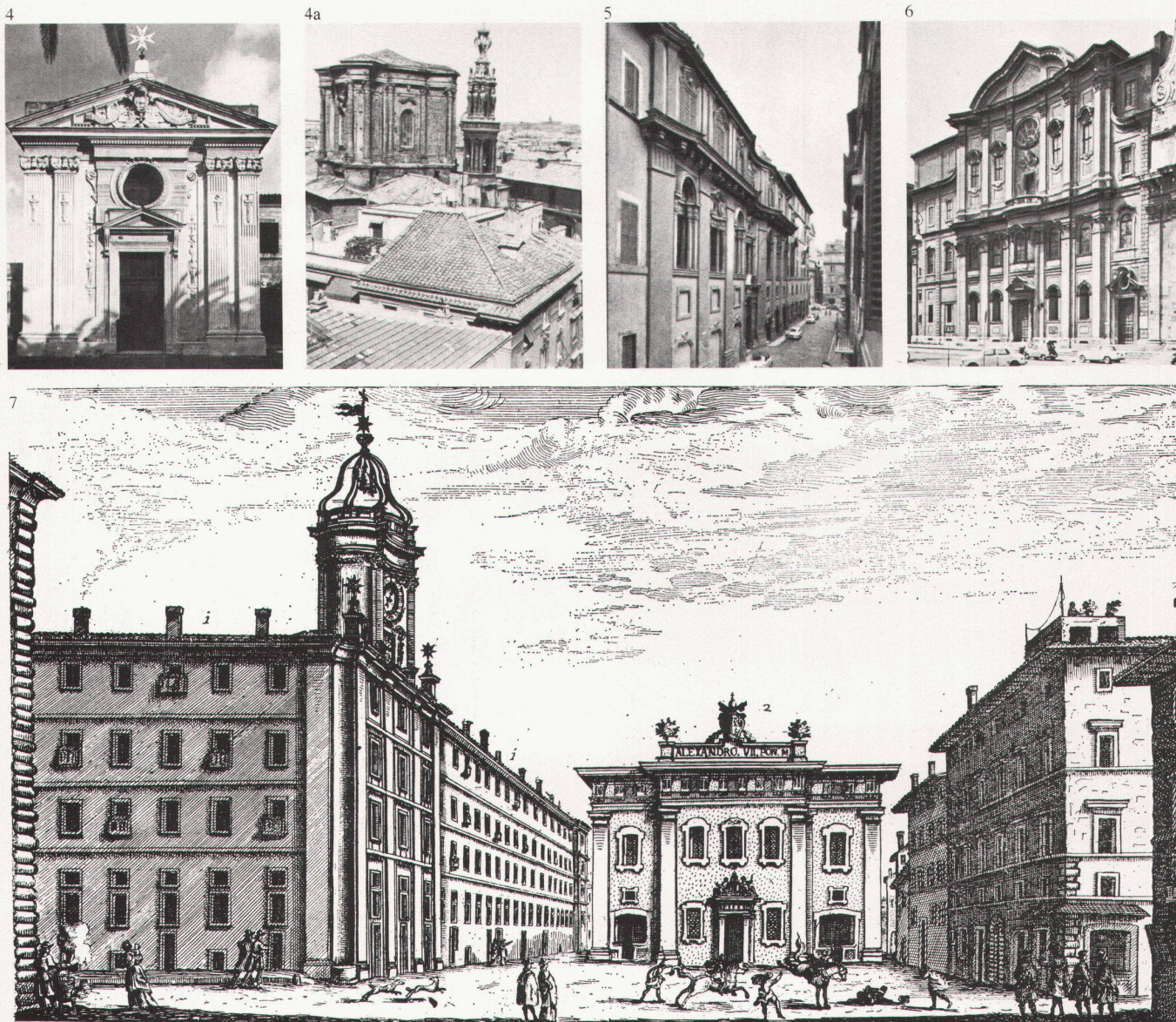
4 G.B. Piranesi: S. Maria del Priorate, Rom. Hauptfassade / Façade principale. 4a Francesco Borromini: S. Andrea delle Fratte, Rom. Tambour.
