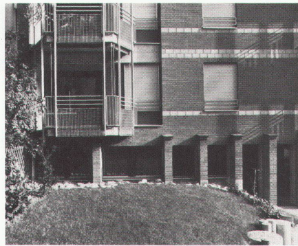
Mehrfamilienhaus Pfeffingerstrasse, Basel 1976 M. Alioth, U. Remund, Basel
