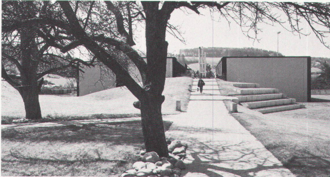
Oberstufenschulanlage Brühlmatt, Birmensdorf 1978 U.J. Baumgartner, Winterthur
