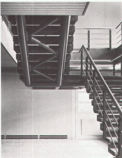
1 2 Details der Treppenaufleger / Détails des départs d'escalier / Details of the stairway supports
