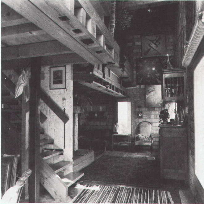
1 Wohnbereich mit eingehängter Schlafgalerie / Partie séjour avec chambre en mezzanine suspendue / Living area with inserted gallery for sleeping
