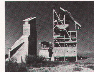
45 Mischwerk einer Kiesgrube 1955/56 (G. Raineri) Via Bramafame (Stura) G 7 L'Architettura, Dezember 1957 L'Architecture d'aujourd'hui, Nr. 139
