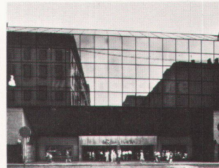
88 Warenhaus «La Rinascente» 1973 (A. Albertini, C. Bordogna) Via Lagrange 12 E 6
